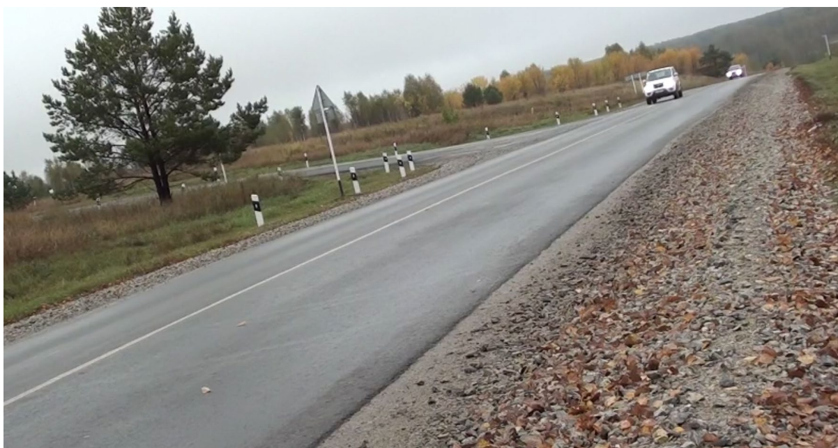
Рисунок 1.8.9 – Наглядное представление существующей схемы ОДД на примыкании а/д муниципального значения 58 км а/д "К-15" – Пайвино к а/д регионального значения 104 км а/д "Р-256" - Черепаново - Маслянино
