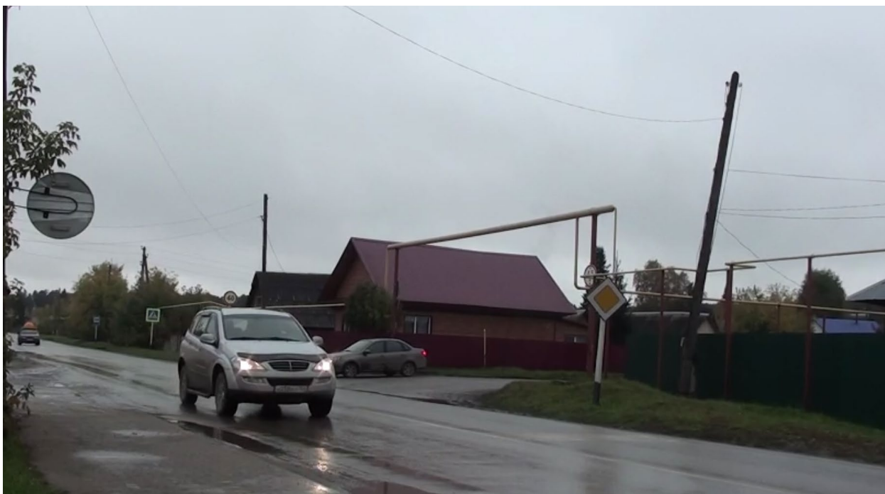
Рисунок 1.8.8 – Наглядное представление существующей схемы ОДД на пересечении ул Садовая и а/д муниципального значения 2 км а/д "Н-1801" - с/х "Маслянинский"
